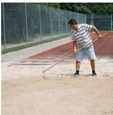
Travaux de finition
